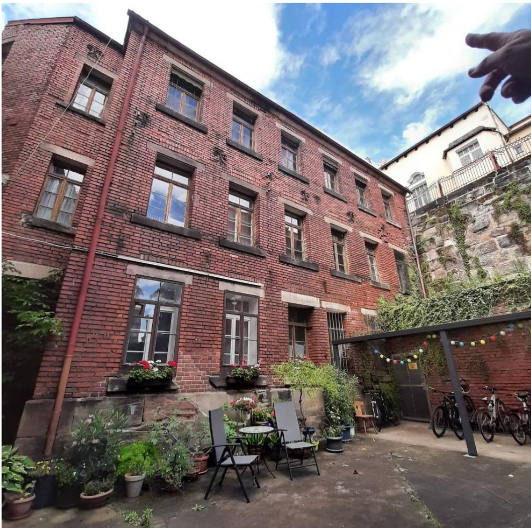
Hier gibt es große Probleme mit Feuchtigkeitsschäden, da das Gebäude direkt an die Stützmauer angebaut wurde. Das Objekt bleibt aber unter Denkmalschutz. Wir hoffen auf eine sachgerechte Sanierung.
